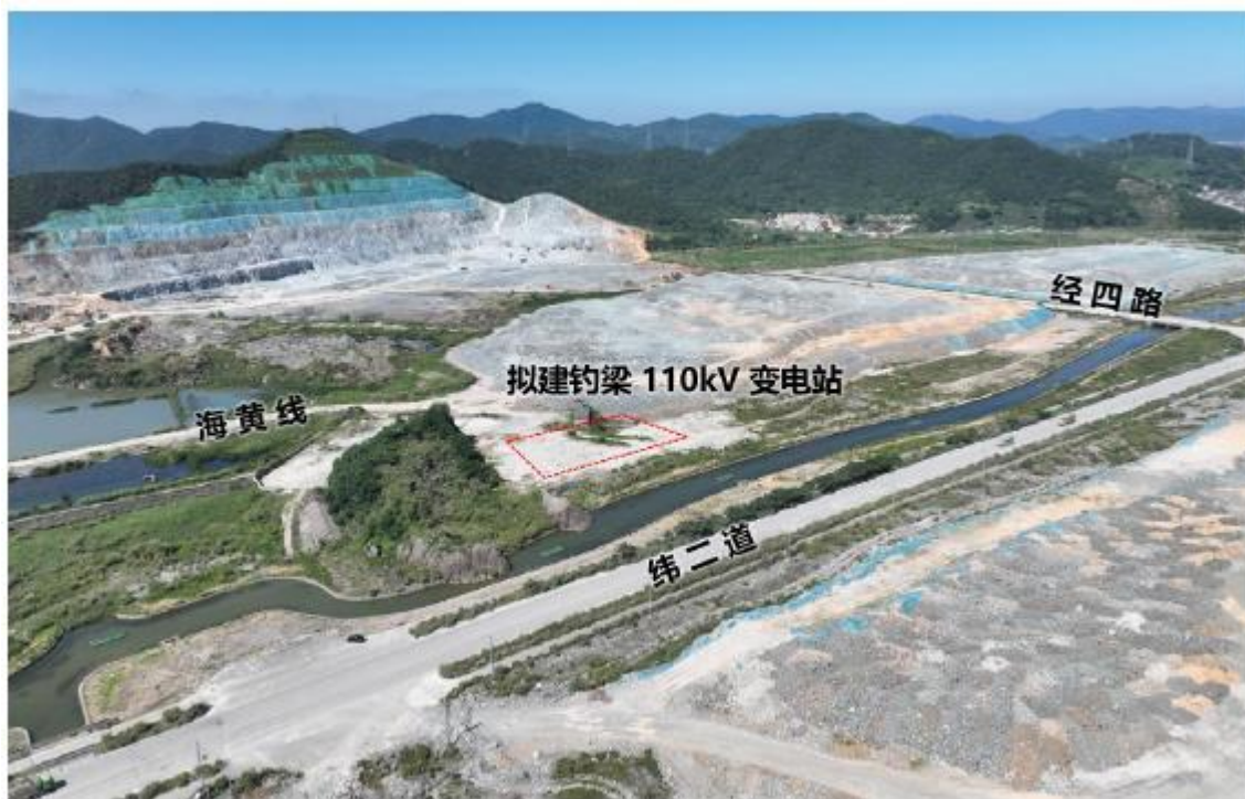
图 3-1 变电站拟建站址现状
