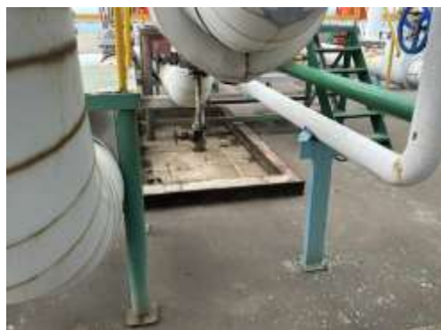
码头集水围堰
