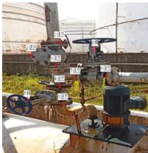
泄漏标识悬挂
