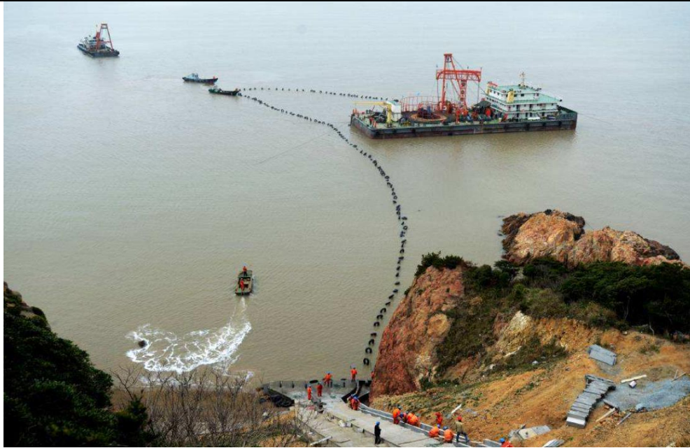
图 2-15 登陆点施工现场图（选自类似工程）
